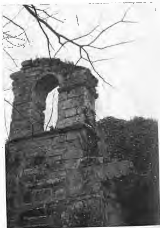
8. Espadaña, ya hueca, sin campana...
