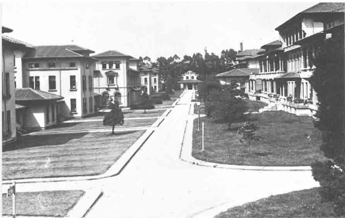
Casa de Salud Valdecilla. Al fondo, la Capilla de la Institución.
