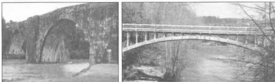
Fotografías 1 y 2 (LV): Dos puentes BIC de Cantabria (de los tres inventariados en este nivel de protección): El puente de Arce sobre el río Pas (de bóvedas pétreas del siglo XVI) y el puente de Golbardo sobre el río Saja (de arcos de hormigón armado de 1902).
