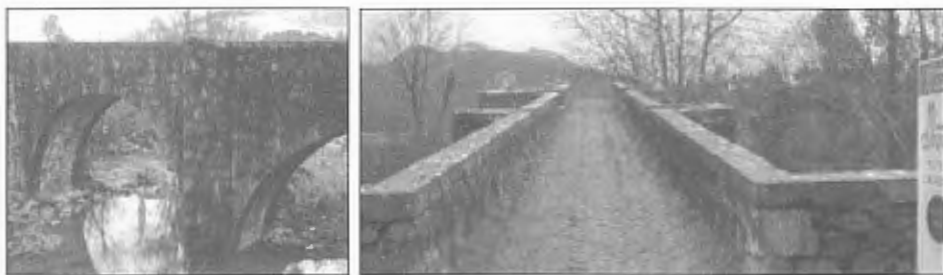
Fotos 15 y 16 (LV): Dos aspectos del bello «Puente Viejo de Ramales de la Victoria» (siglo XVII): A la izda. se muestra su alzado aguas arriba, donde destacan sus tajamares de sección triangular, y a la dcha. sus pretils y el pavimento encachado.
