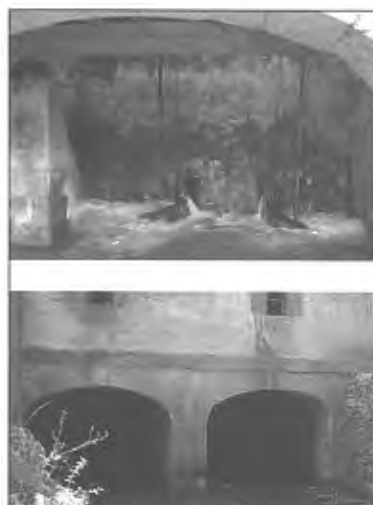
Foto 8. Estolda del molino de Entrepunte. Ramales de la Victoria-
