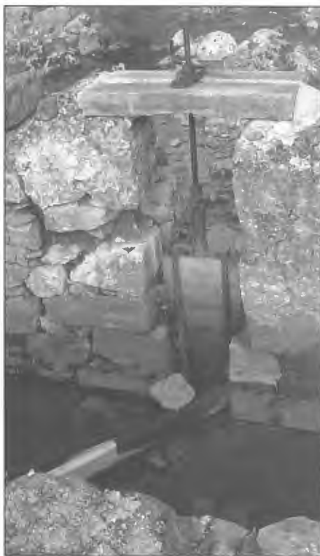
Foto 5. Sangradera del molino de Entrepuentes. Ramales de la Victoria.
