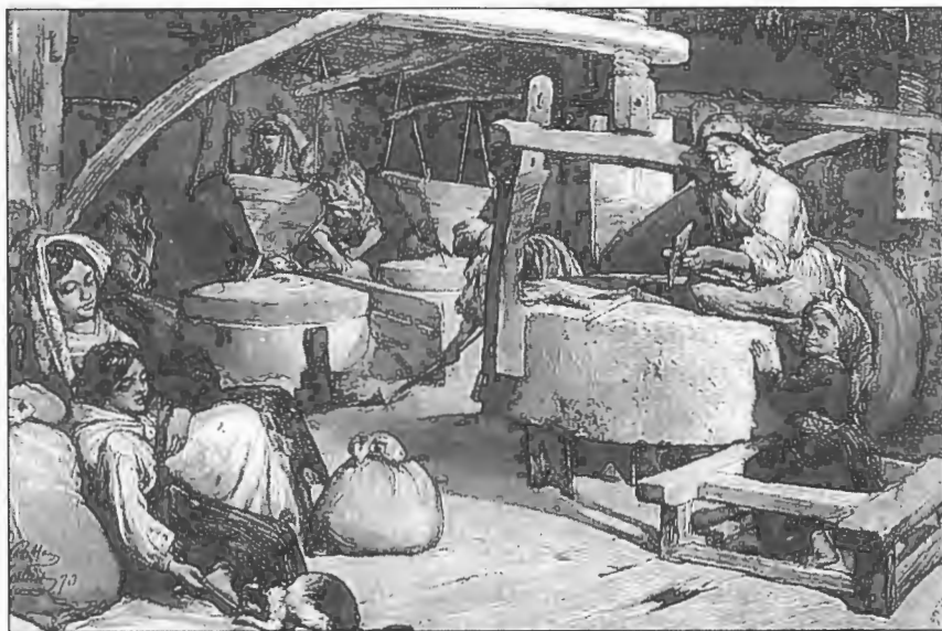
Foto 30. Picando el molino. Fuente: La Ilustración Española y Americana , 1874, n° XXVIII.
