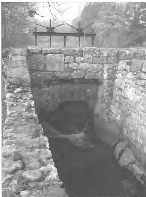
Foto 4. Comportas, inicio de canal de Entrepuentes. Ramales de la Victoria.
