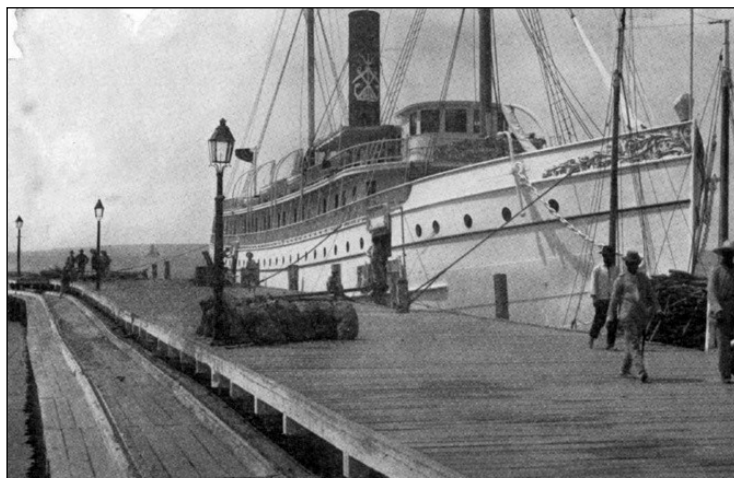
El Reina de los Ángeles , gemelo del Purísima Concepción , también construido en el astillero Neafei & Levy, con casco de acero y cinco mamparos estancos.
