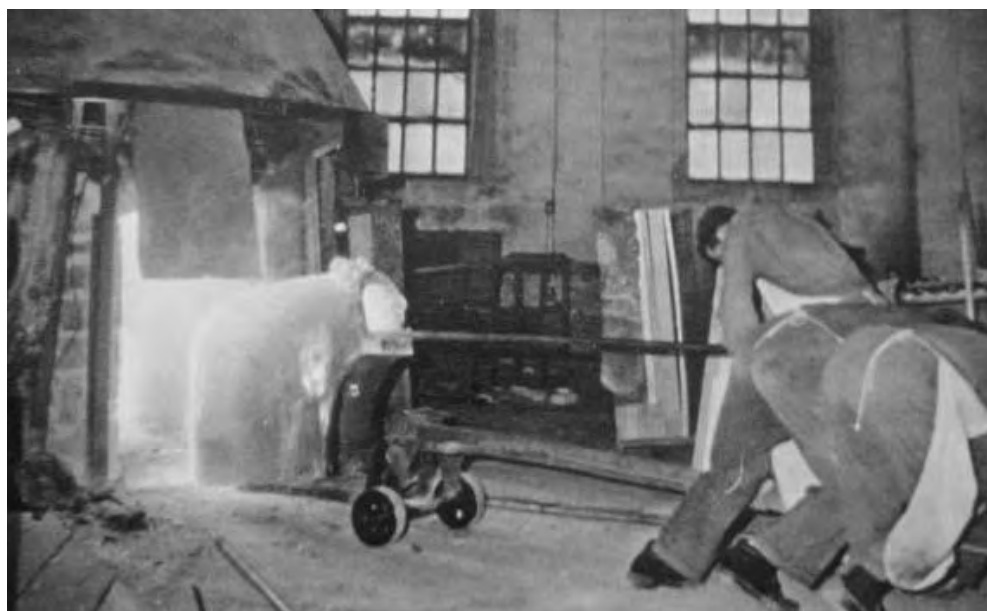
Recambio de un crisol en La Vidriera de Maliaño.
