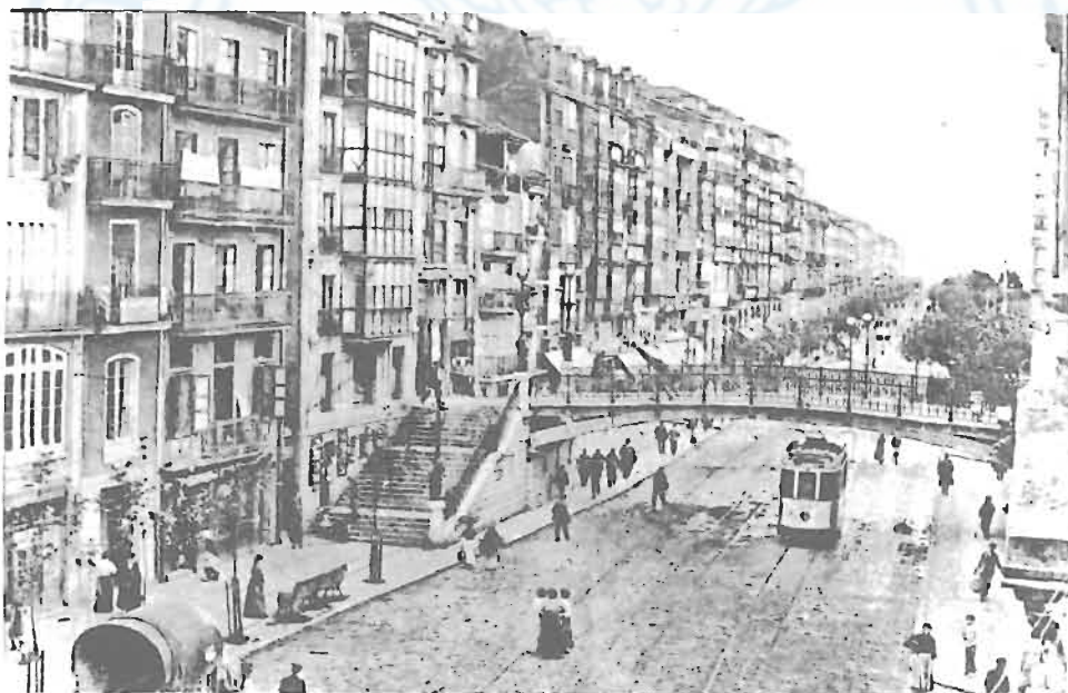
TRANVIA DE NUEVA MONTAÑA (antiguo urbano).—Electrificado el 16 de julio de 1908. Fotógrafo: Alvarez y Leveriel. Madrid.
