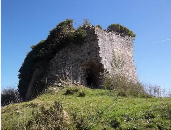
Fig. 3.9.5. Torre de Cobejo. Se aprecia el importante grosor de los muros, que superan los 3 m de anchura.
