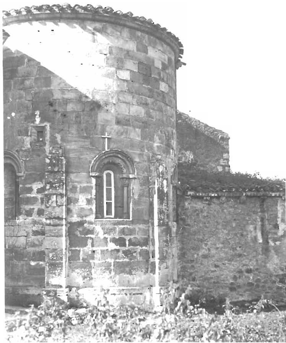
22.—Abside románico de la Iglesia de Villasevil.
