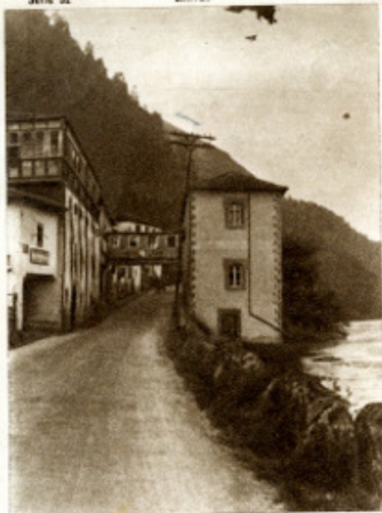
La carretera y el Ayuntamiento
