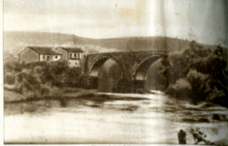
Una vista del puente
