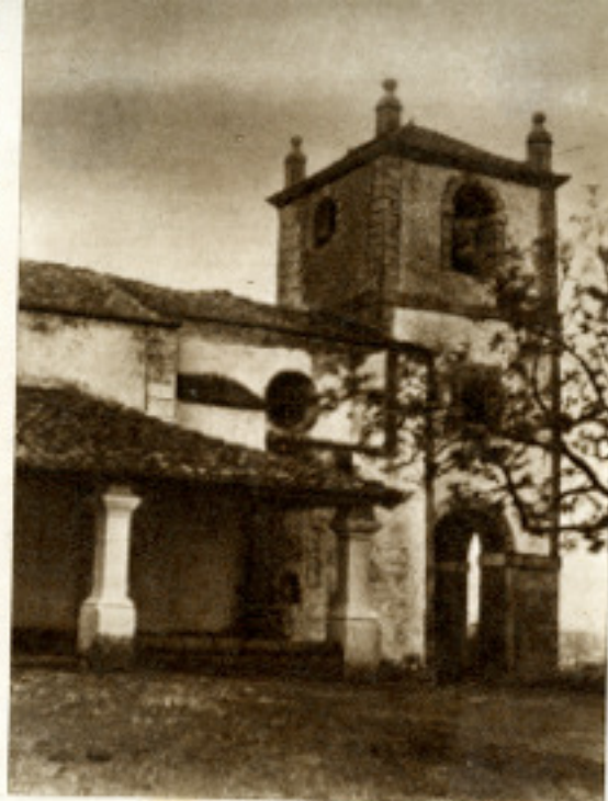
Pórtico y campanario de la Iglesia
