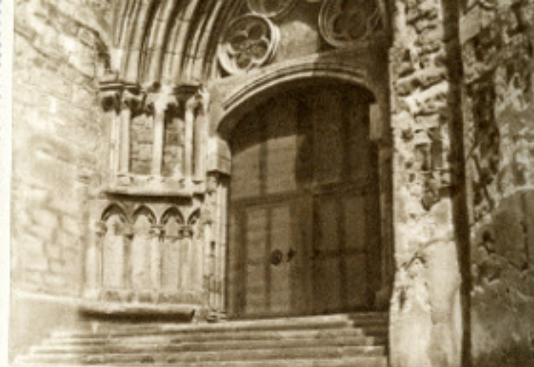
Pórtico de la Iglesia del Siglo XIII
