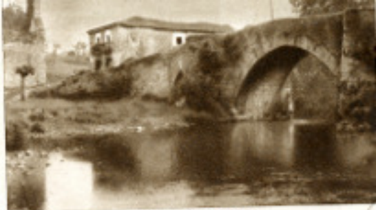
Puente sobre el río
