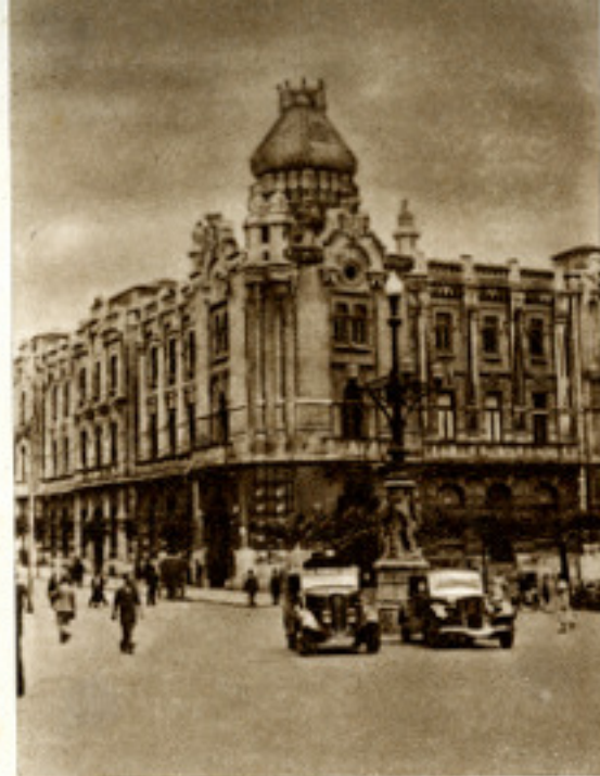
Fachada principal del Ayuntamiento
