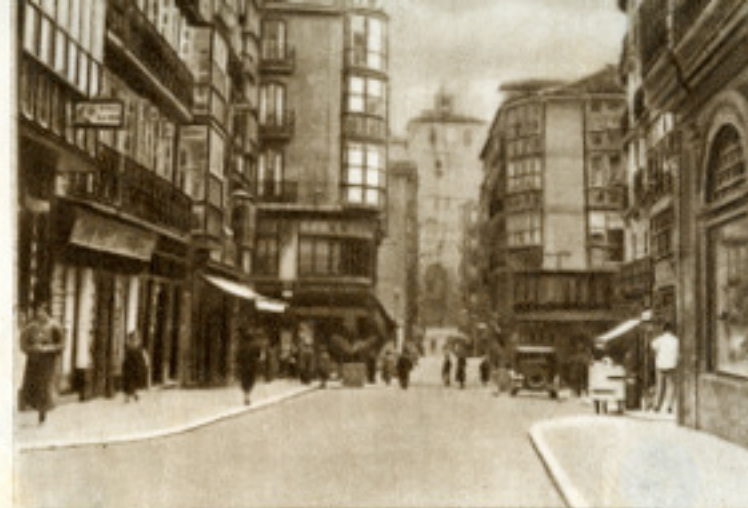
La calle del Puente
