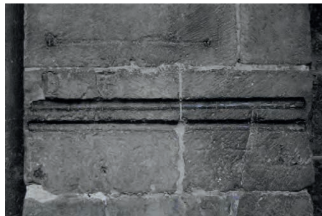
Figura 3. Vara jaquesa cuya medida es equivalente a 0,77m, conteniendo tres pies de 25,7cm y dos codos de 0,385m siendo esta medida el espesor del muro donde se ha tallado el arco objeto de este estudio.
