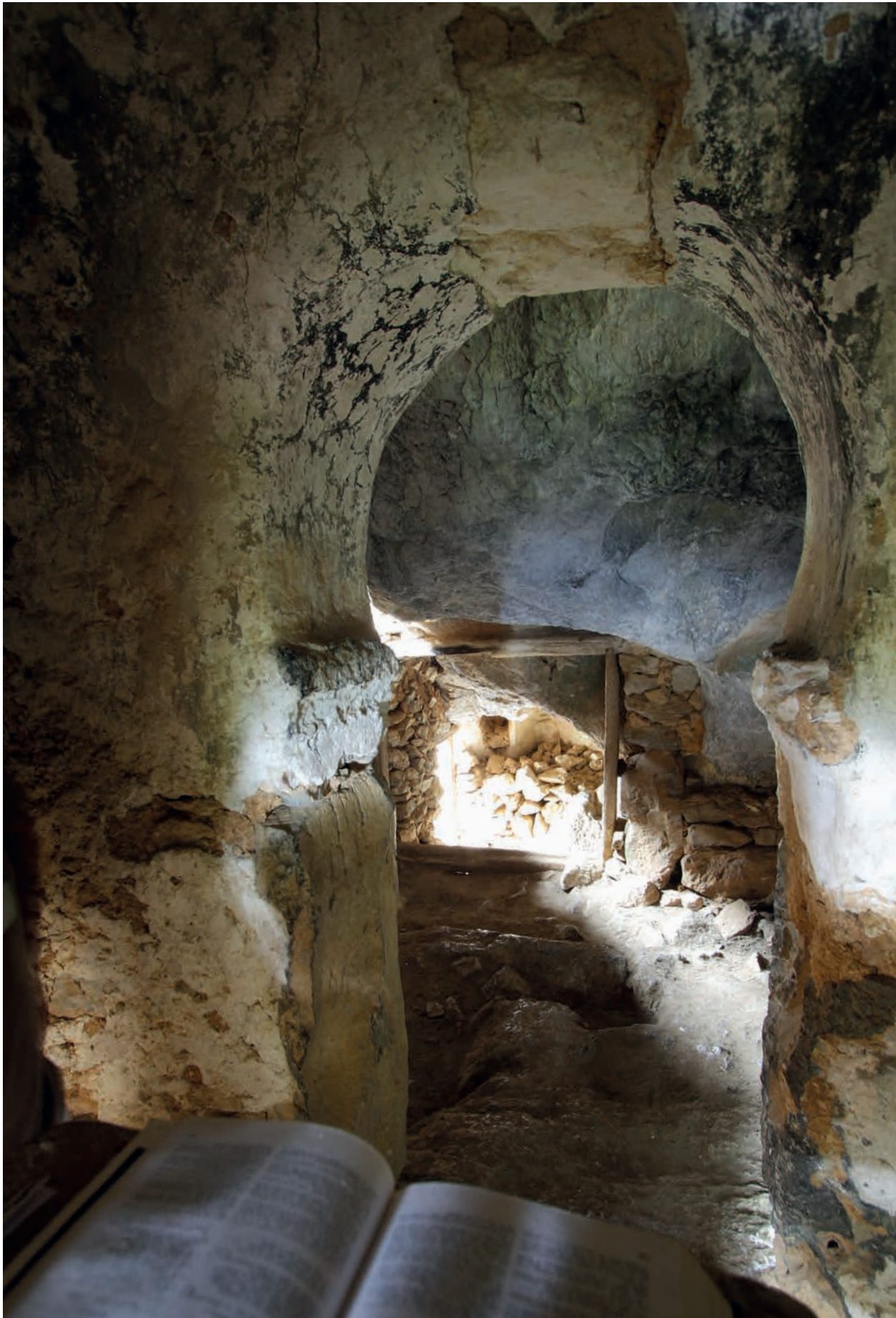
Figura 33. Vista interior del arco toral de herradura donde se aprecia la clave y el retallado de las impostas.
