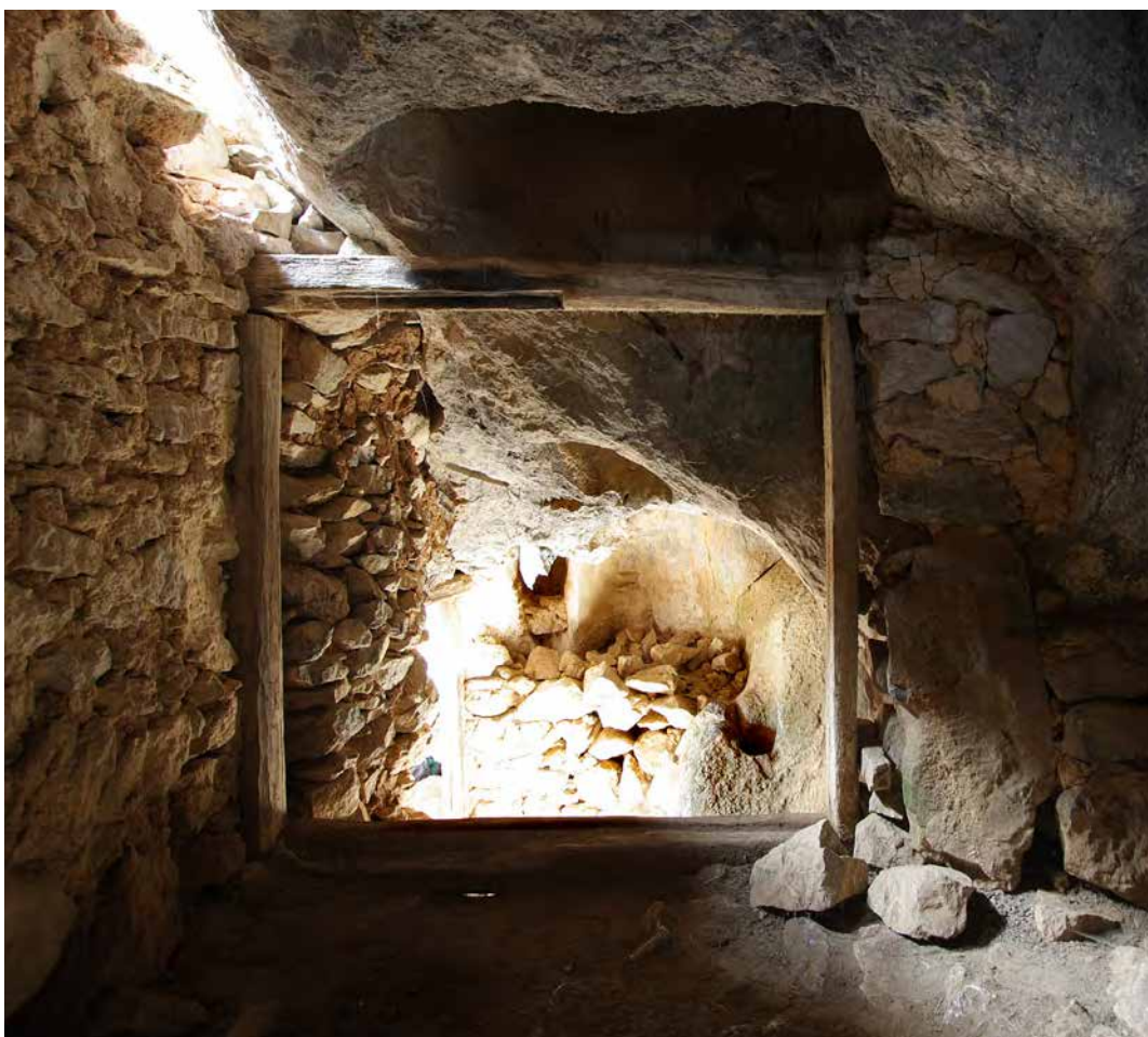
Figura 22. Vista del marco original de la puerta de ingreso desde el interior. Obsérvese el rebaje en el lateral izquierdo que permitía la apertura de la puerta hacia adentro.
