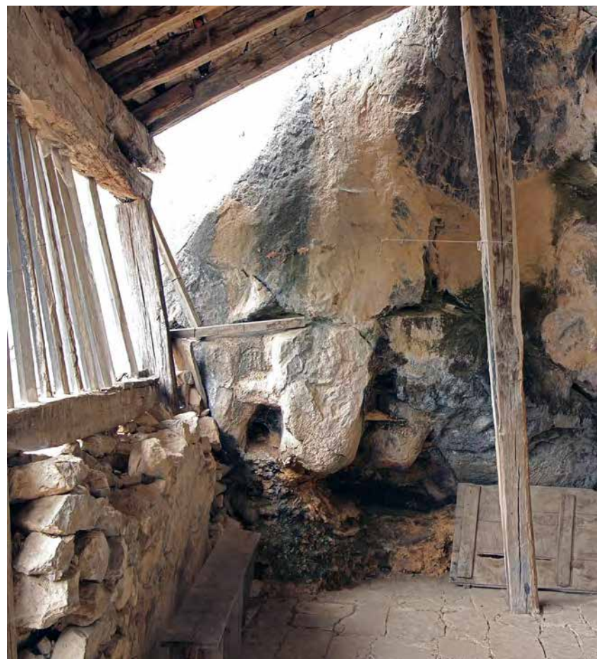
Figura 14. Vista interior del porche del s. XIX, con el acceso a la ermita tardoantigua a la derecha y donde se aprecia la principal patología del conjunto: una inclinación hacia el exterior que amenaza con su caída.
