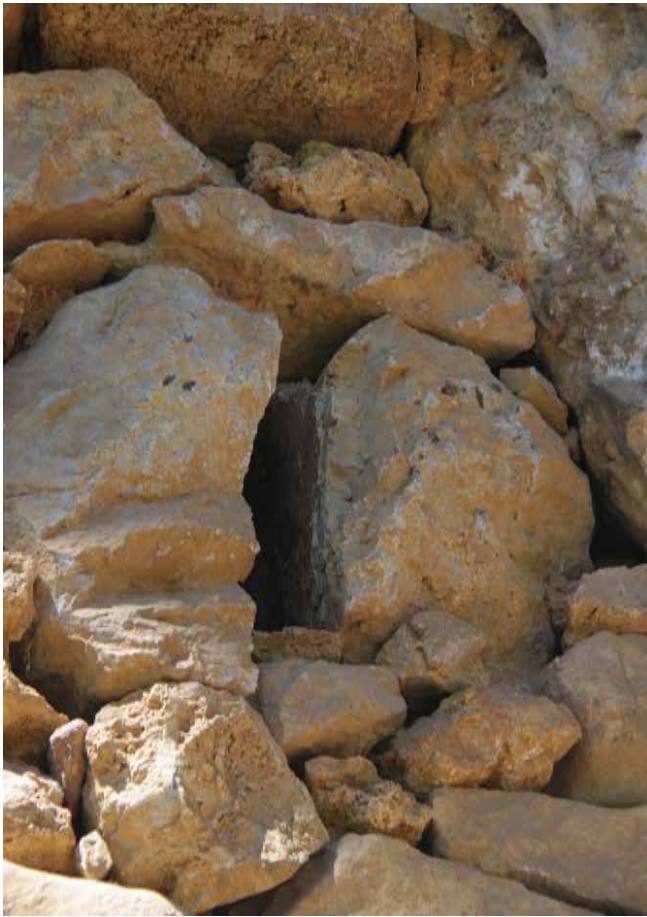
Figura 31. Vista exterior de la aspillera de iluminación del ábside, donde se puede apreciar su estructura a base de grandes lajas monolíticas.
