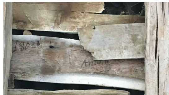
Figura 17. Tablazón de la ripia del s. XIX, con varias de las tablas firmadas y fechadas.
