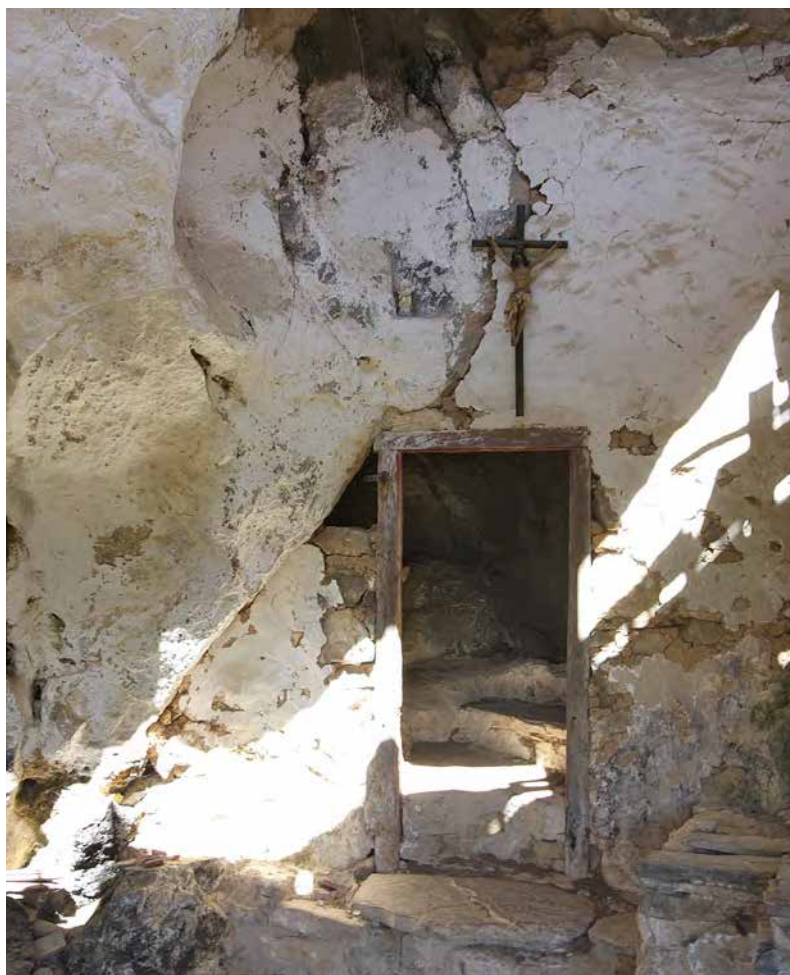
Figura 20. Puerta de ingreso a la ermita tardoantigua levantada en el s. XIX, sobre la que se aprecia la huella tallada de un mechinal, tal vez parte de un tejadillo que protegería la entrada original.
