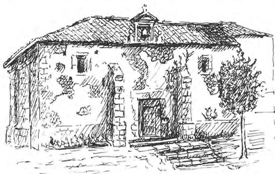
Fig. 168.—Ermita de la Gracia antes de su reparación.
