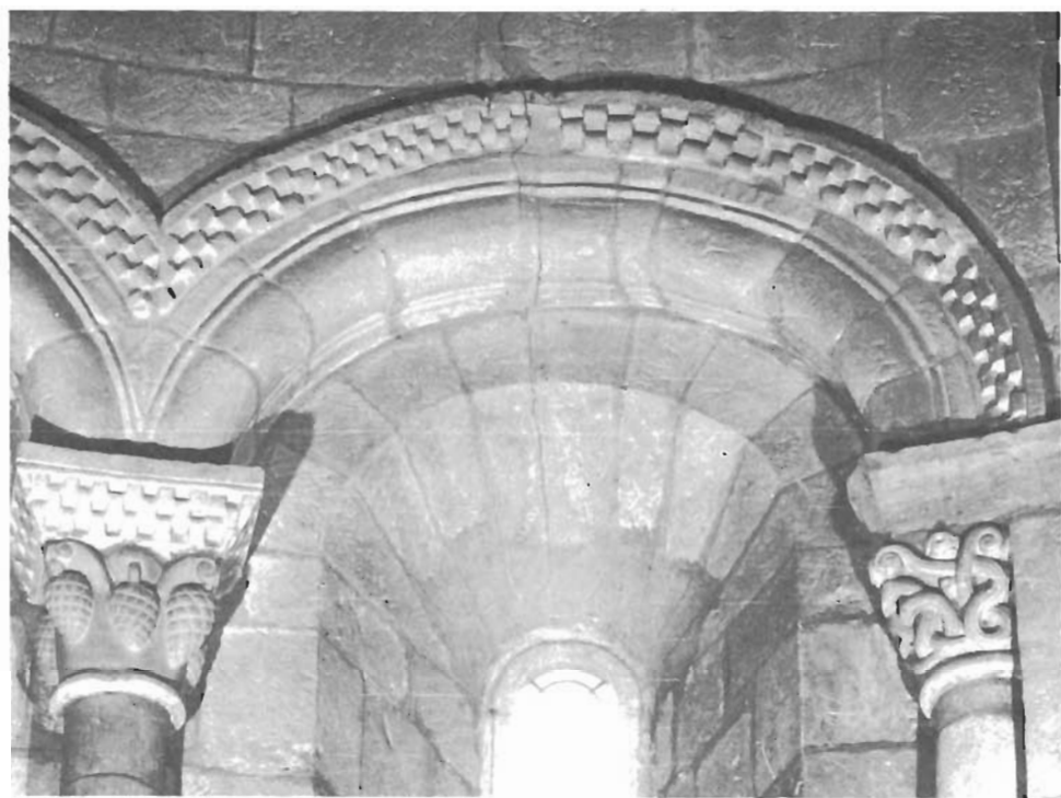
Capiteles de arcada superior de abside. N.º 40
