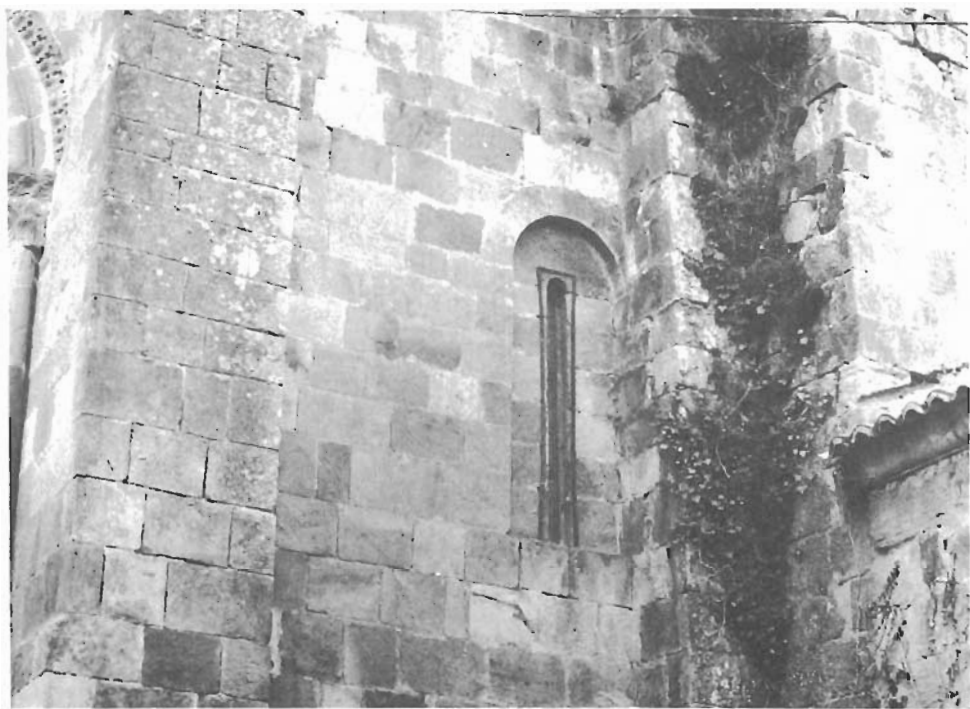
Contrafuerte izquierdo posterior. Ventana de tramo y estribo original. N.º 8 bis S. Martín de Elines.
