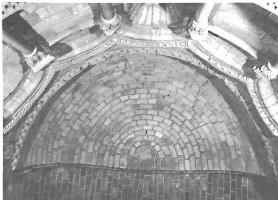
Bóveda de abside y perspectiva de la arqueria superior. N.º 9
