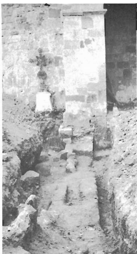
Cimentación original. N.º 5
