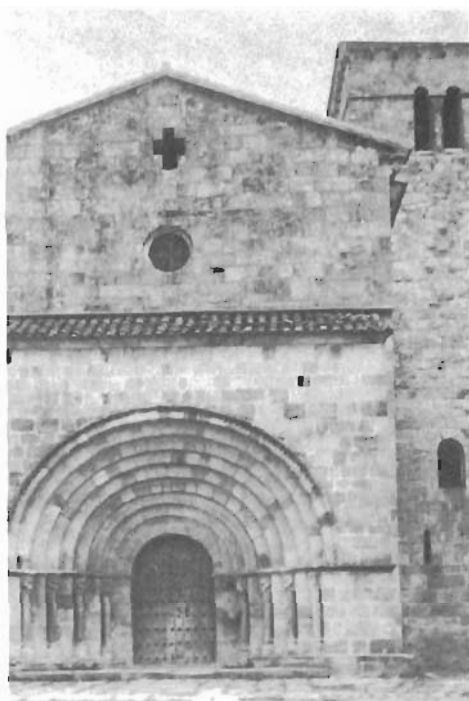
Fachada oeste. N.º 1
