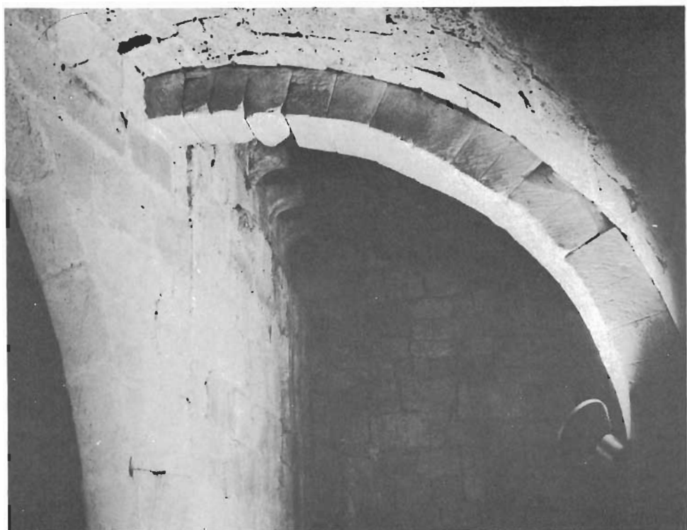
Lienzo de muro hasta los modillones. Prerrománico. Románico el resto. N.º 8
