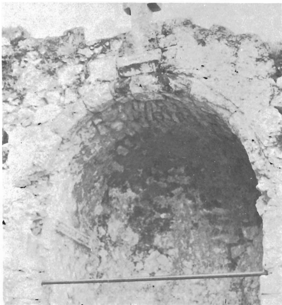
Abside prerrománico arco peraltado bóveda de cañón. Estilo asturiano. S. IX. Inédito
