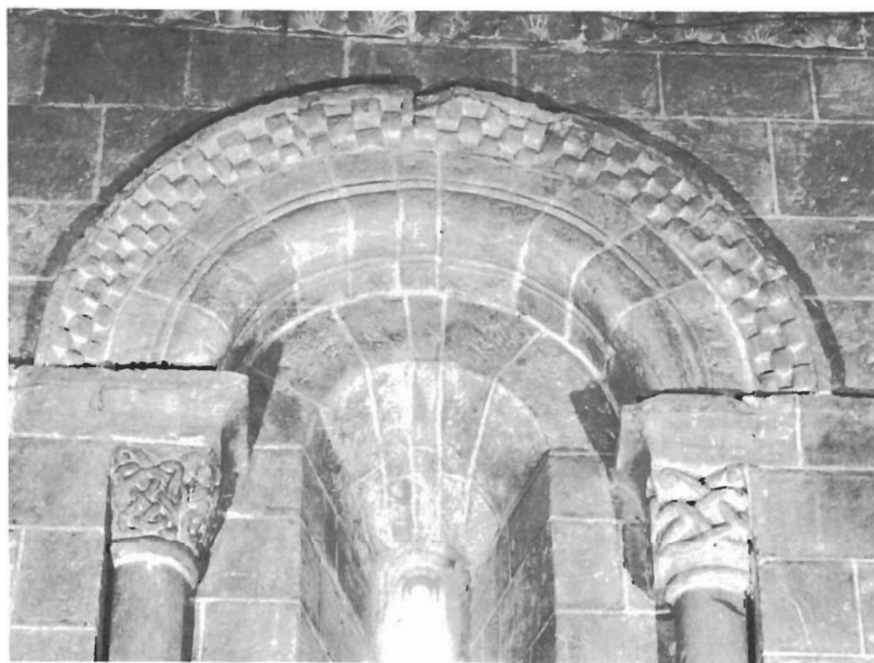
Ventana interior de tramo - Posición alzado N.º 23
