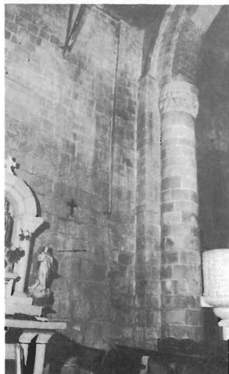
Obra original, columna, pilar y banda, reconstrucción forro de muro. N.º 29
