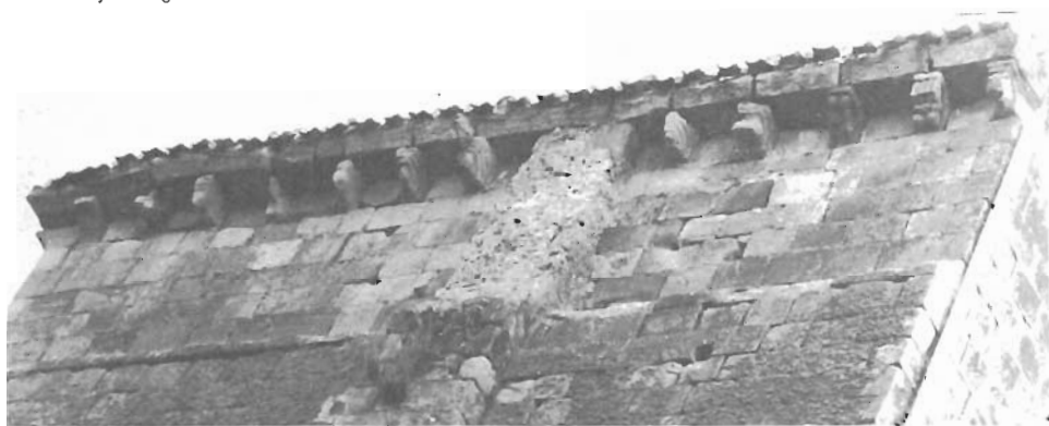
Contrafuerte plano desde la base a la cornisa, posición cimborrio. Fachada norte. N.º 26
