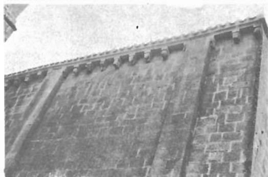
Sepúlveda. Estribos fachada sur. N.º 11 bis
