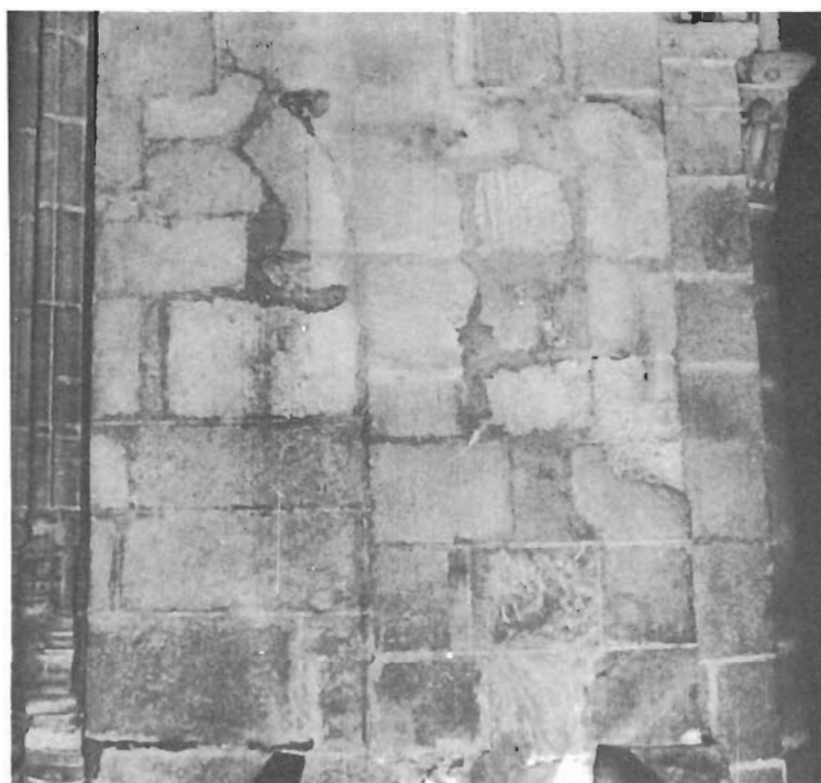
Lienzo de muro prerrománico de arco ciego. N.º 1
