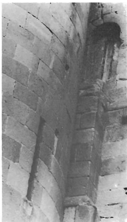
Vanos de luz de torre y fachada pral. N.º 13
