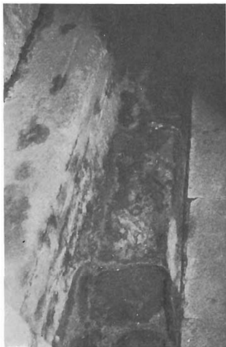
Cimentación original. N.º 5
