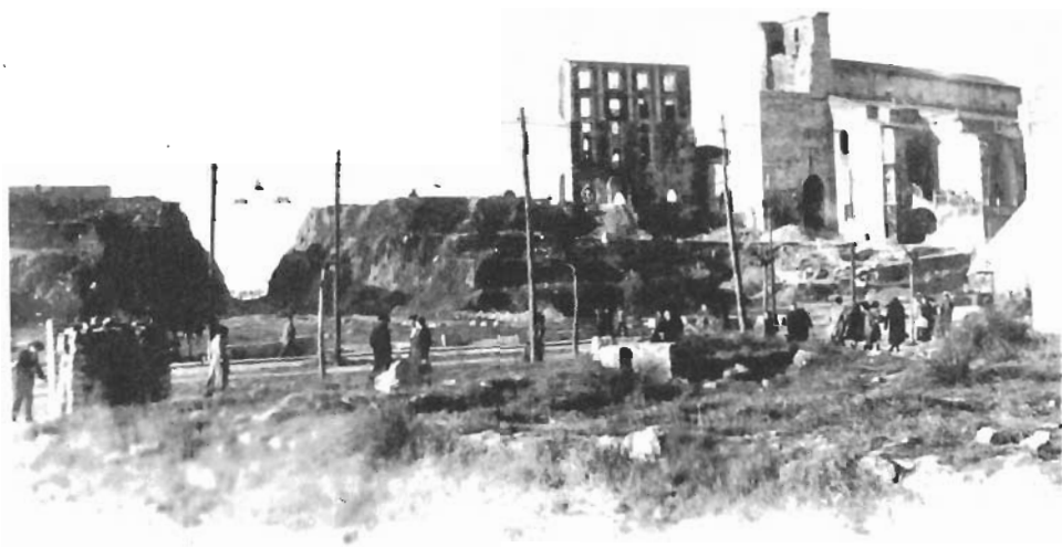
8-9.—De las ruinas de la catástrofe, desechos y desmontes, hacia la nueva ciudad. Aquí está el espacio físico inesperado que se le ofreció al Nuevo Régimen para levantar su arquitectura, su ciudad.
