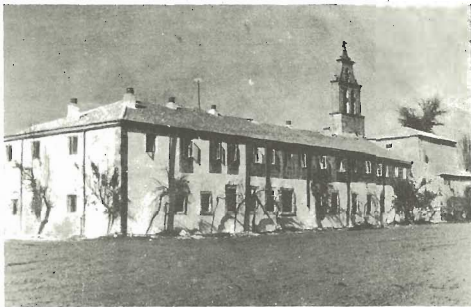
Fig. n.º 48.— Fachada posterior del Hospital-Asilo de Reinosa.
