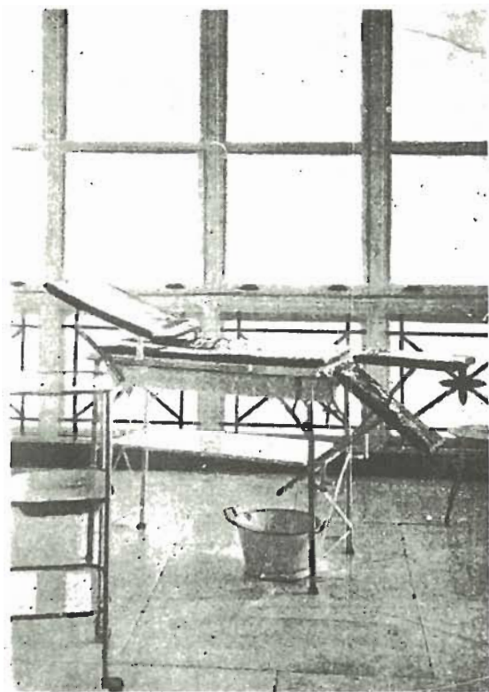
Fig. n.º 68.—Casa de Salud. Parte de la sala de operaciones del Hospital de San Rafael. Año 1912.
