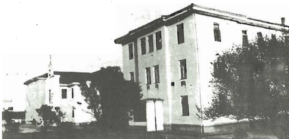
Fig. n.º 91.— Fachada frontal orientada al Norte de la Casa de Maternidad. Año 1929.
