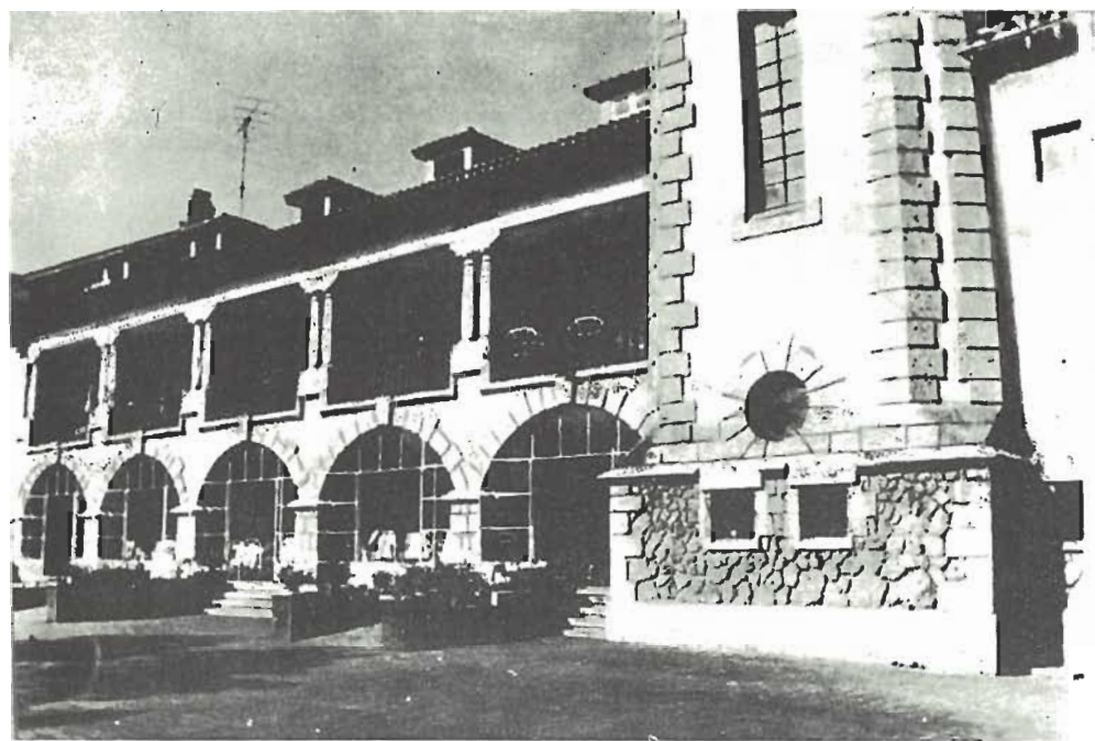
Fig. n.º 87.—Detalle de uno de los pabellones del Sanatorio Marítimo de Pedrosa.
