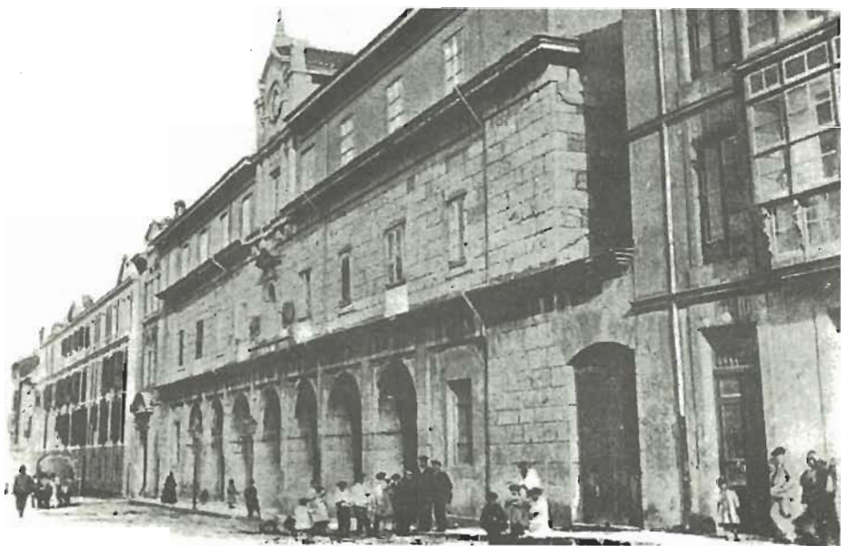
Fig. n.º 64.—Hospital de San Rafael, realizada la ampliación con el aumento de una planta más. A continuación la Casa de Caridad. (Foto Duomarco).
