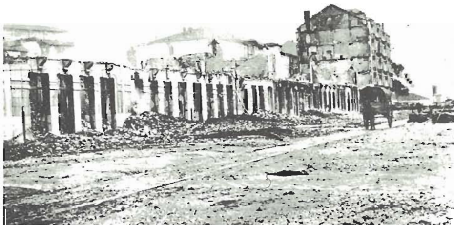
Fig. n.º 54.—Estado en que quedaron las casas frente al lugar de explosión del vapor Machichaco. Año 1893. (Foto Duomarco).
