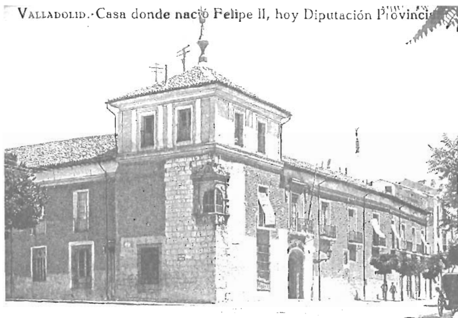
Obsérvese el parecido del balcón esquinado con el del Palacio de Villatorre.
