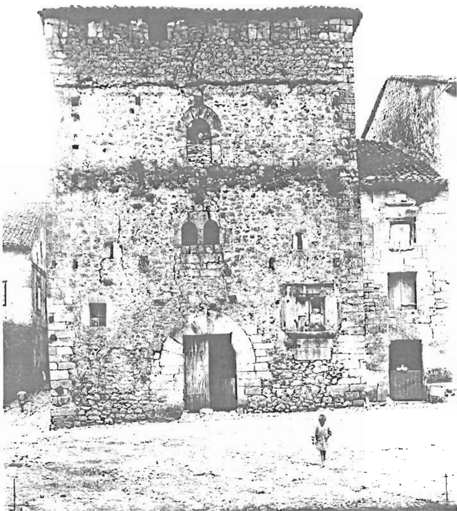
Casa primigenia de los Barreda conocida como Torre del Merino, o "La Torrona". Foto tomada en las primeras décadas del siglo XX. La puerta gótica de acceso, ha sido retallada, desgraciadamente, en dintel. Defecto corregido después con motivo de su restauración. Archivo CEM.
