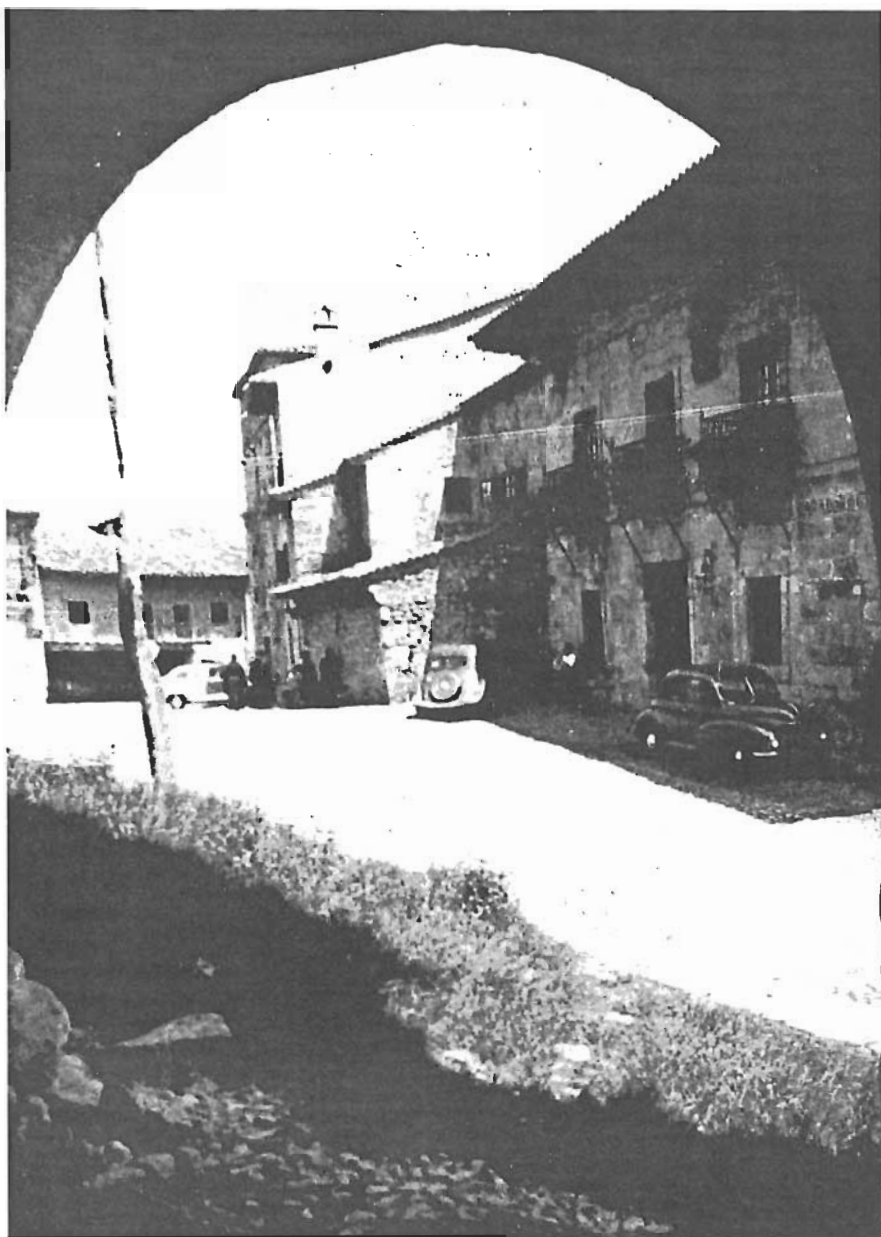
Casa de Barreda y Bracho, actual Parador Nacional Gil Blas en Santillana del Mar. Al fondo la llamada casa de Barreda (de la Plaza) a la que se reunió la de Barreda-Bracho (Archivo CEM).
