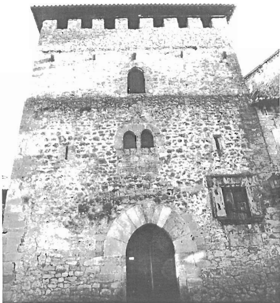
Torre del Merino. Estado actual.
