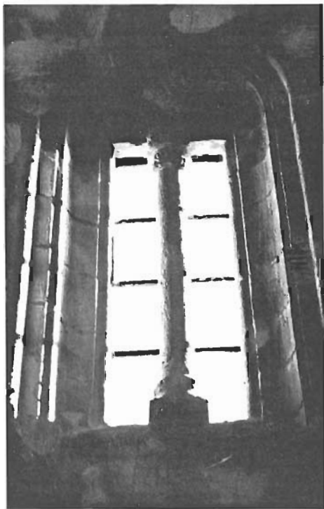
Vista interior de la ventana de la capilla gótica.
