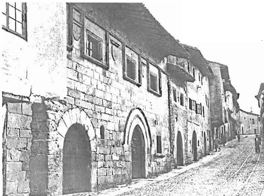
Casa de Doña Leonor de la Vega en la calle del Cantón en Santillana del Mar. Archivo CEM.
