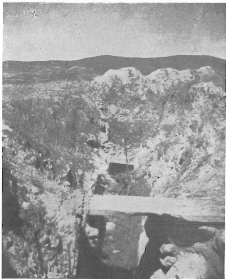
Vista del aliviadero del algibe, tomada de S-N.
