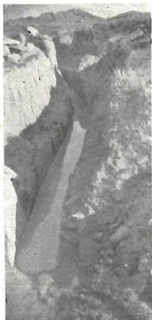
Parte inferior del alcantarillado número 2.
