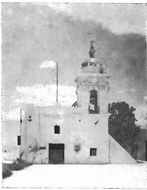
Iglesia de Santander-Jiménez (México). «La iglesia de esta Villa... es de seis varas de ancho, ocho de alto y veinte y seis de largo... una torre en su me- dia naranja enladrillada de azulejos». (S. Butrón en 1788)
