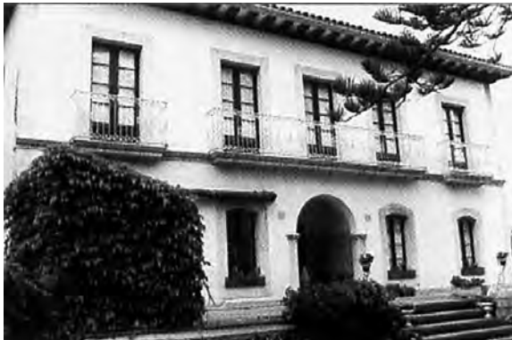
Casa en la que vivió Manuel de Ygual en la Villa de Noja, construida en 1870, es de planta rectangular con dos pisos y cubierta a cuatro aguas, en ella se combina la cantería tradicional con la simplificación volumétrica y decorativa propia de la arquitectura de la época.
