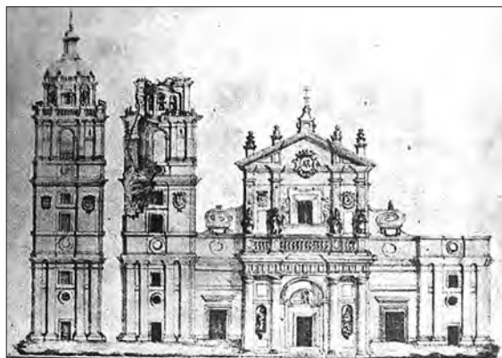
Dibujo de Isidoro Domínguez Díez que muestra la fachada de la Catedral de Valladolid en donde se observa el derrumbe de la torre en 1841.
