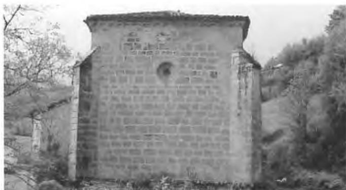
Cabecera con contrafuertes en esquina.
