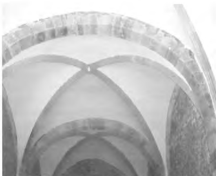
Bóvedas en el interior.
