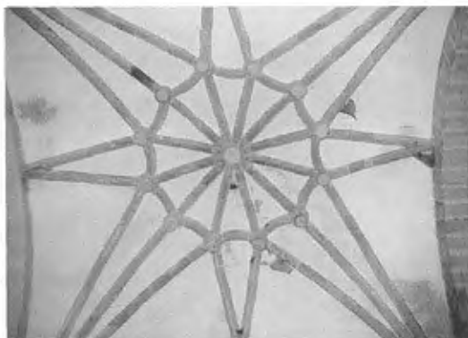
Bóveda de crucería.
