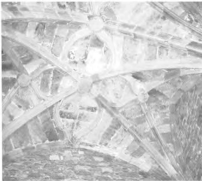
Bóveda del transepto.
