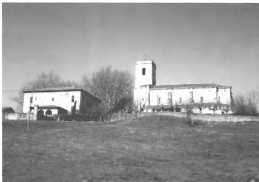
Vista general de la Iglesia de S. Cipriano y del palacio de Villa-Vierna.
