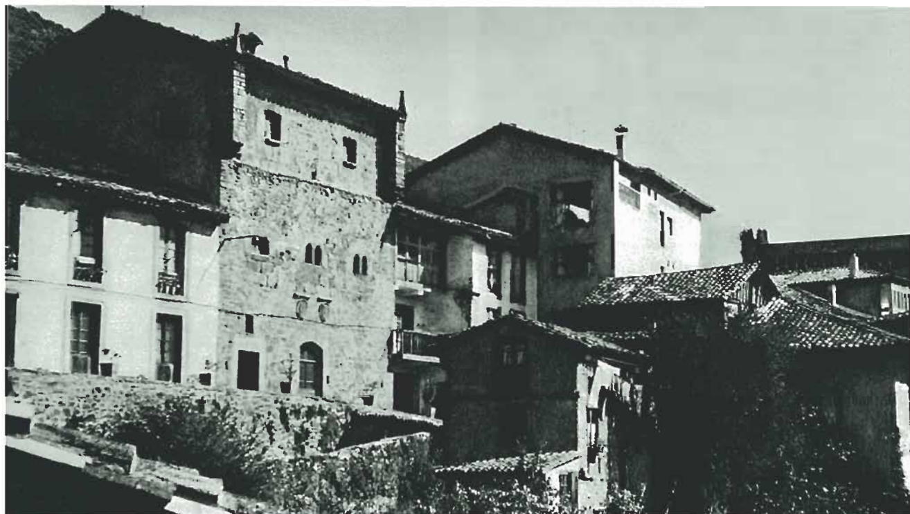
182 a. Torre llamada de «OREJONES», que era de BEDOYA. Potes.
