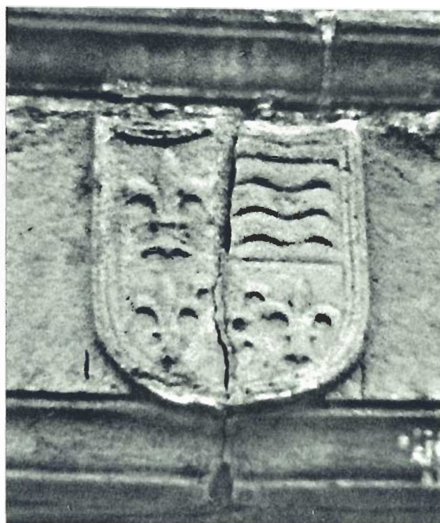
130. Armas de ALVARADO en la Torre. Heras.
