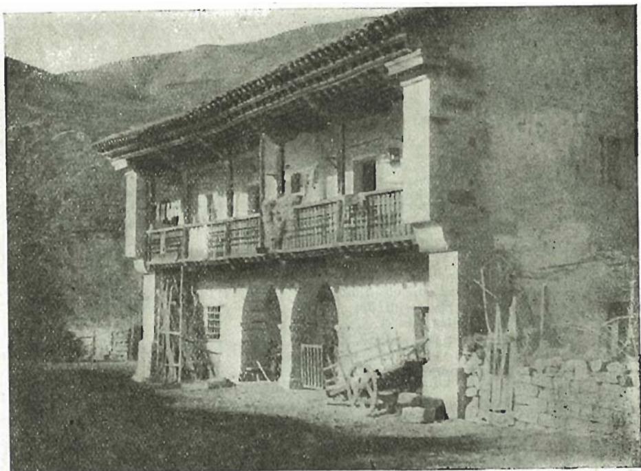
Casa solariega típica de una aldea montañesa. La parte superior se destina a la vivienda y la inferior, al alojamiento del ganado. Nótese el cortafuegos y la solana, los dos elementos de construcción característicos de la casa montañesa
