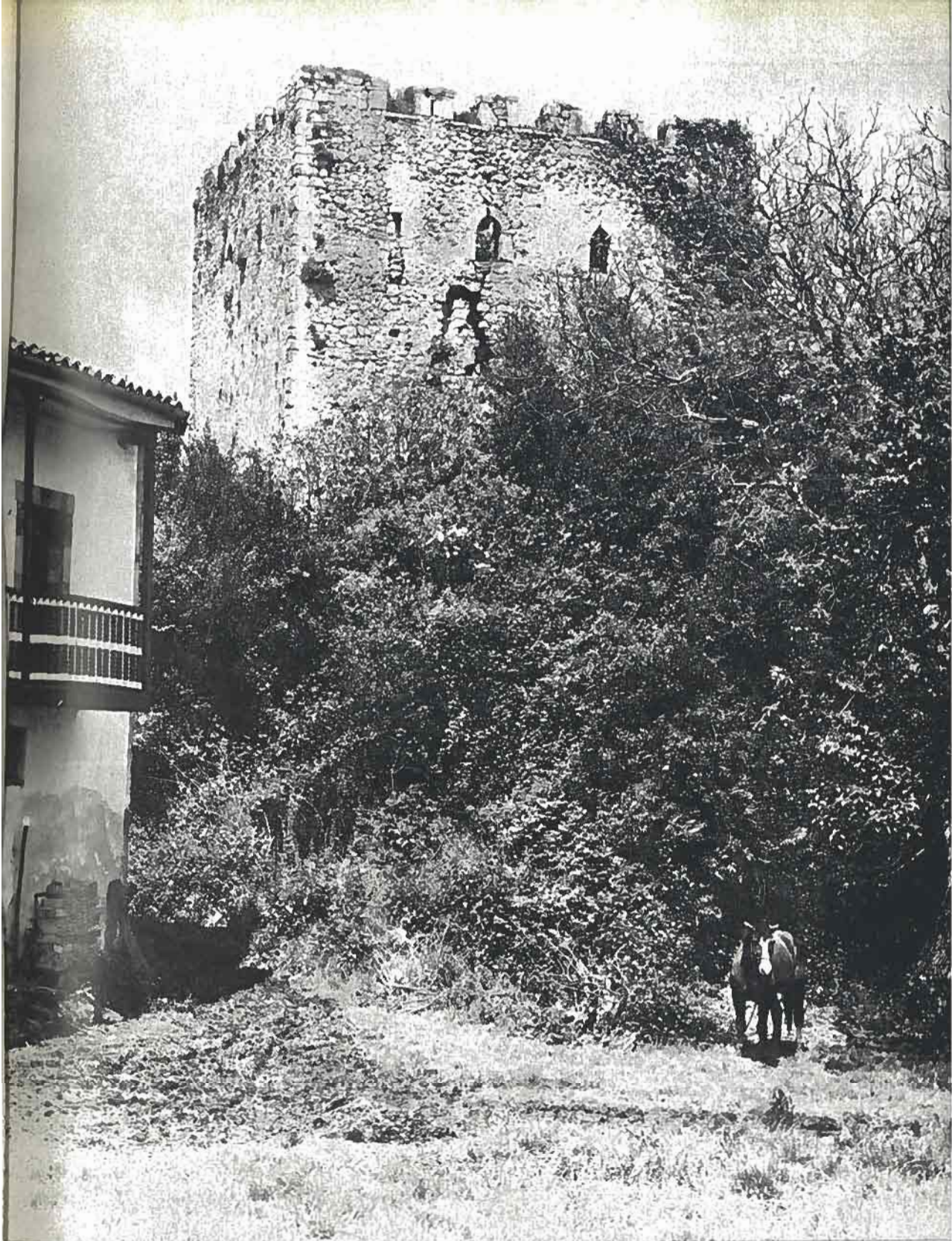
Otro aspecto del estado actual de la Torre. (Fot. F. Santamatilde).
