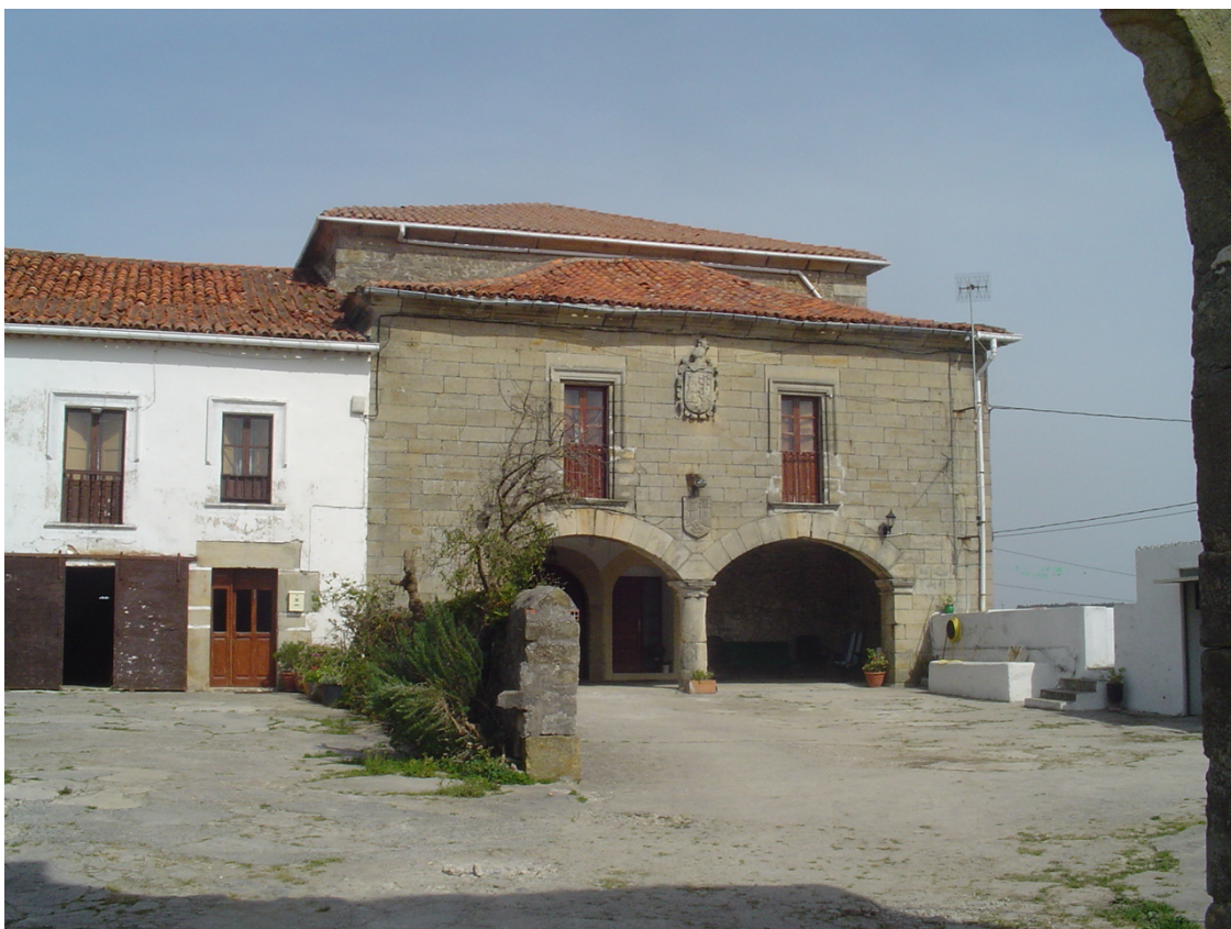
Portalada, torre y casona de Pedro de Llabad Camino, Tesorero y Secretario de la Inquisición de Logroño, que en la fecha del naufragio del vapor “Carranza”, servía de cuartel de carabineros.
