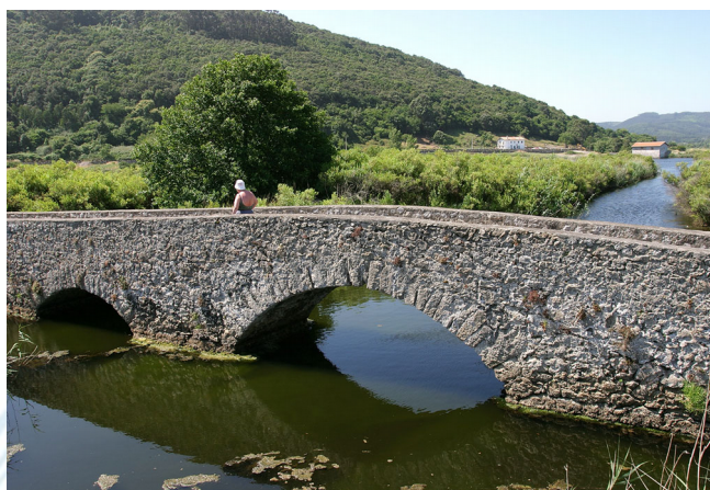
Noja. Puente de Elgueras.
