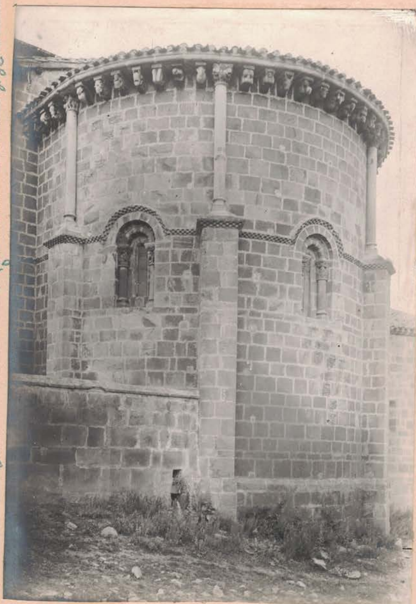
Vista exterior del abside
