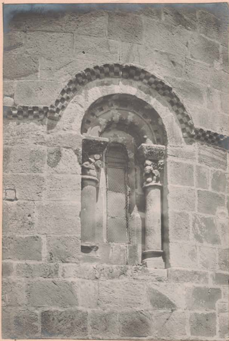
Ventana exterior del abside.
